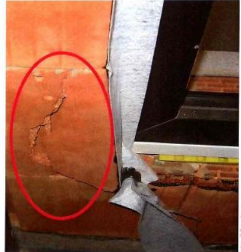
Ausbrechende Mauerwerkssteine: Solche Probleme entstehen, wenn die Befestigungsmittel nicht auf das Mauerwerk abgestimmt sind und der Randabstand nicht eingehalten wurde.
