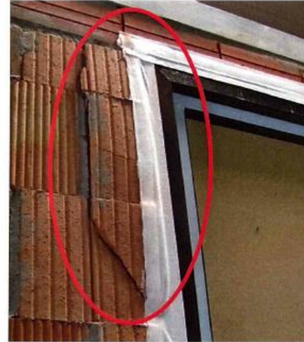
Ausbrechende Mauerwerkssteine: Solche Probleme entstehen, wenn die Befestigungsmittel nicht auf das Mauerwerk abgestimmt sind und der Randabstand nicht eingehalten wurde.
